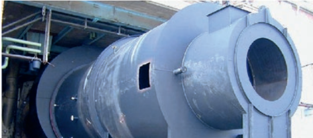
SAACKE Heißgaserzeuger während der Montage
